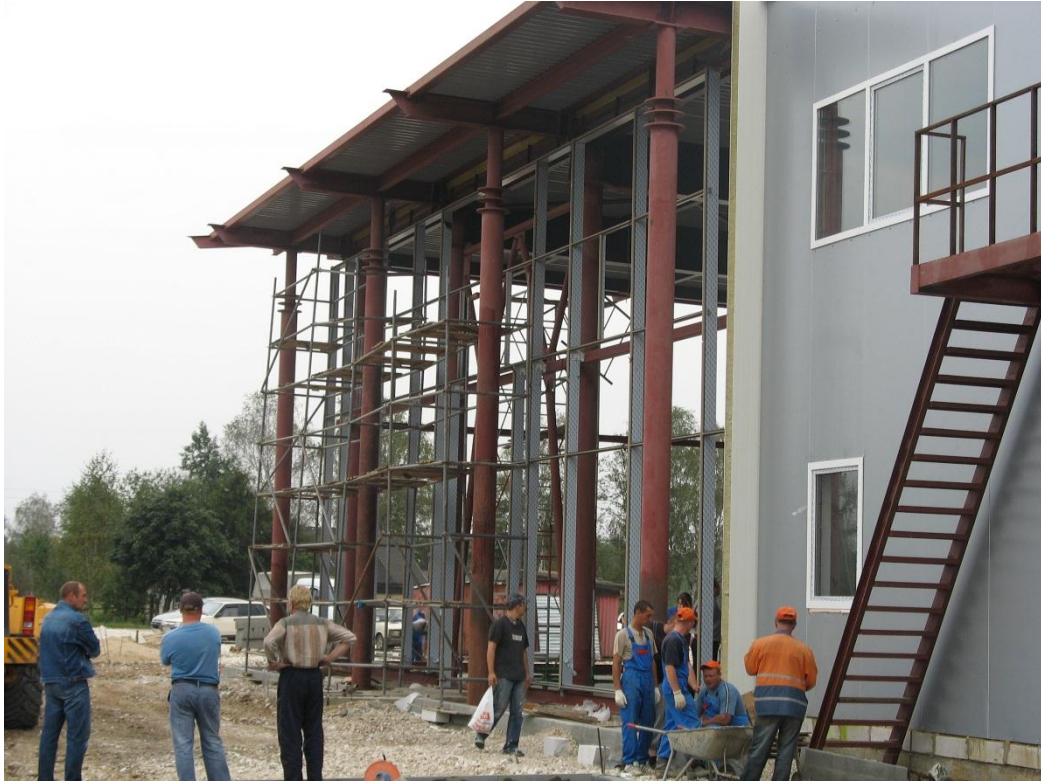
Строительство технического центра автомобилей «MAN» в п. Строителей
