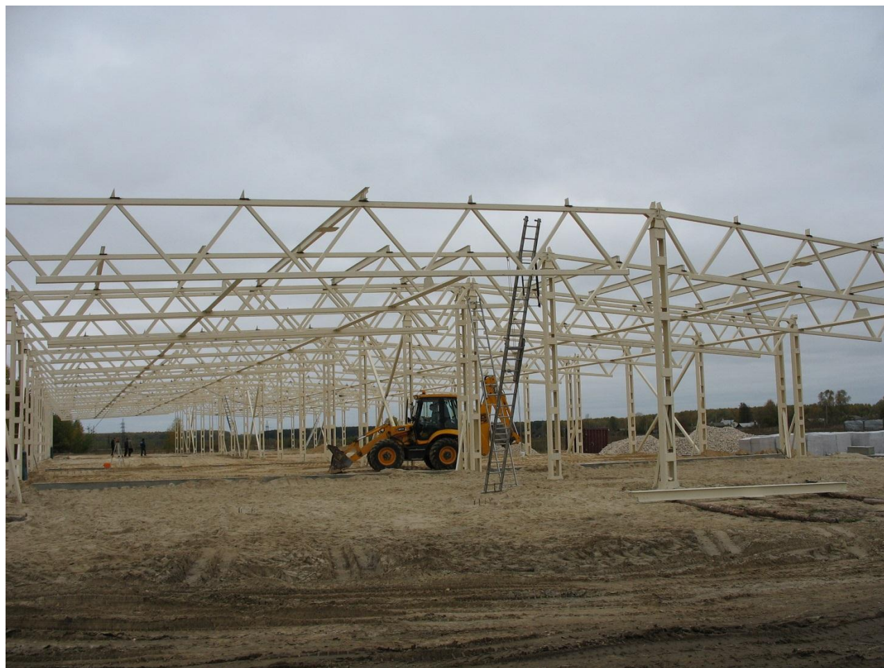
Строительство склада в Богородском районе
