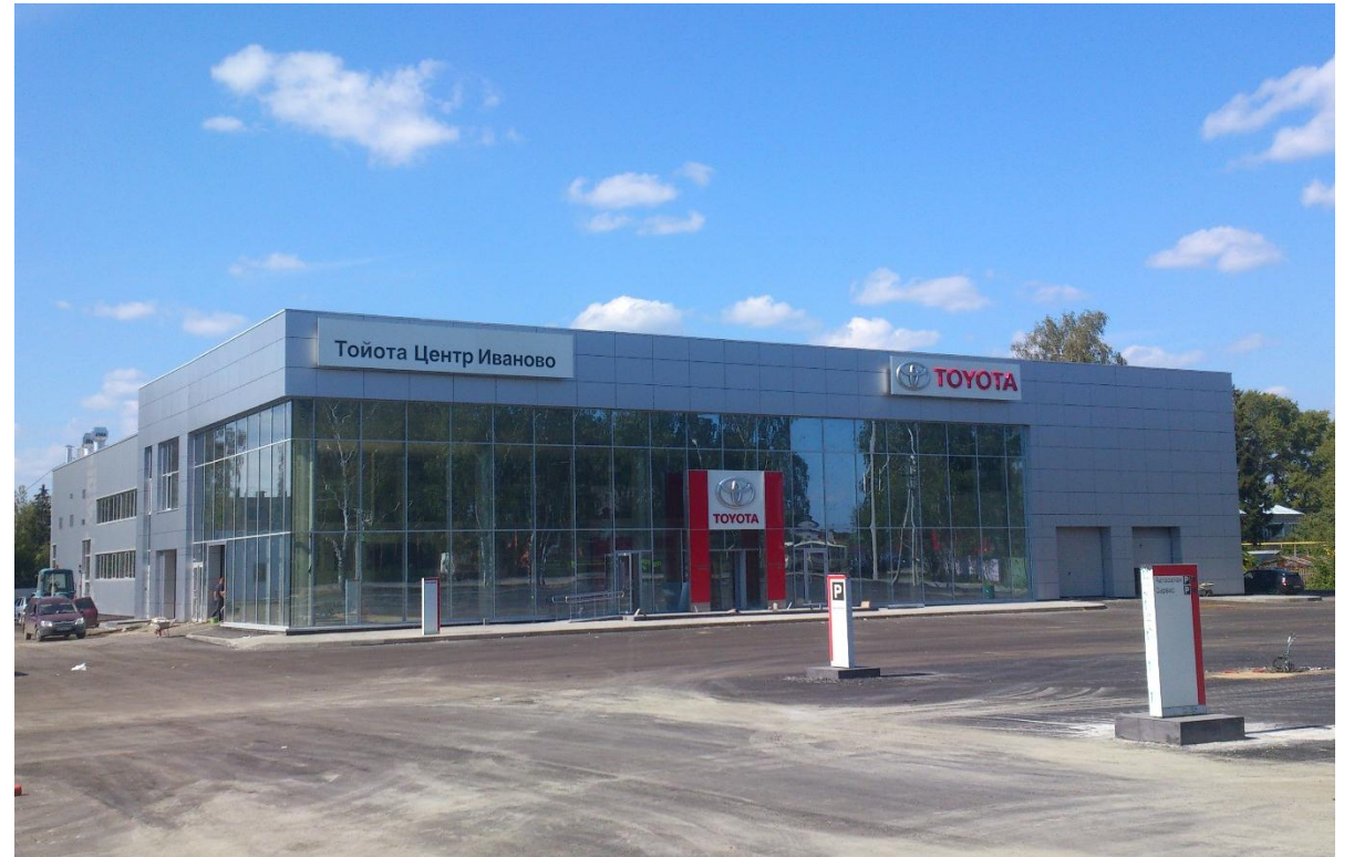
Строительство автосалона «ТОЙОТА» в г. Иваново
