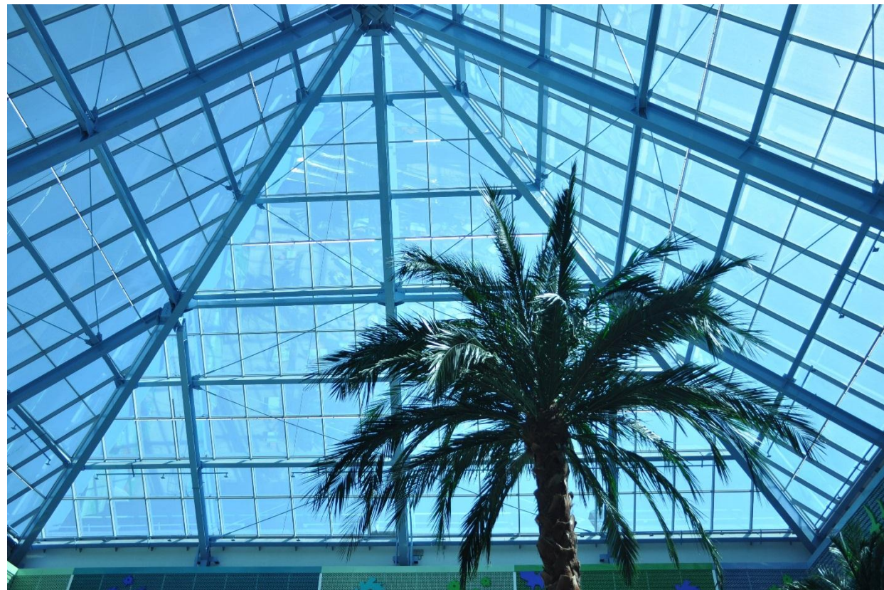
Световые фонари покрытия ТРЦ «Седьмое небо» в Нижнем Новгороде
